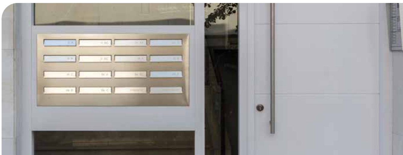
Detalle de la vista desde el exterior del portal.
